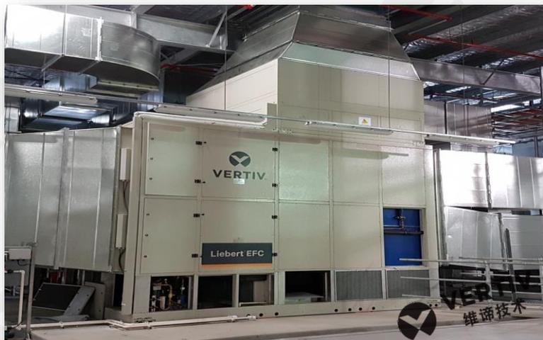
EFC300间接蒸发冷却
